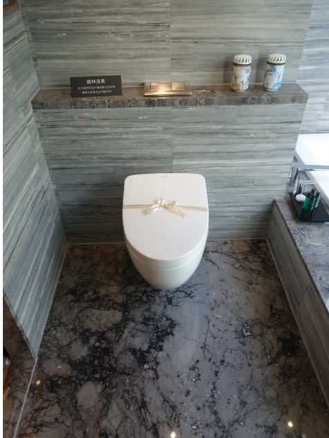
浴廁地坪天然石材+牆面磁磚
